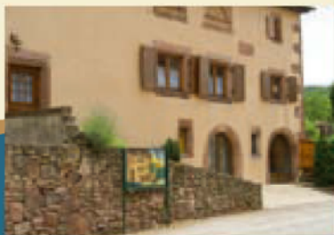
Saint-Pierre-Bois : La maison dite « des Suédois ».
